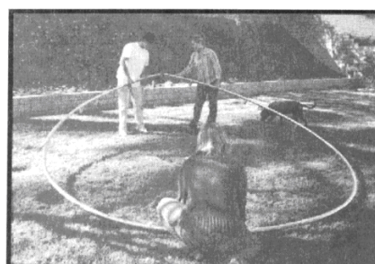
4 Продолжайте, пока Вы не получите большой круг. Для соединения последнего звена нужно трое взрослых здоровых людей в хорошей физической форме. При помощи третьего человека, державшего противоположные концы, соедините обе стороны круга вместе и зафиксируйте небольшими шурупами.
